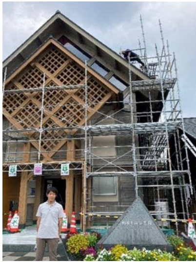
②外壁工事中の記念館
